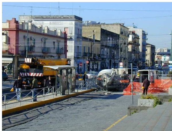
Figura 4 I lavori in corso in via Nuova Poggioreale
