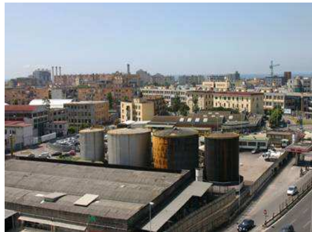
Figura 4 I serbatoi dell'area industriale
